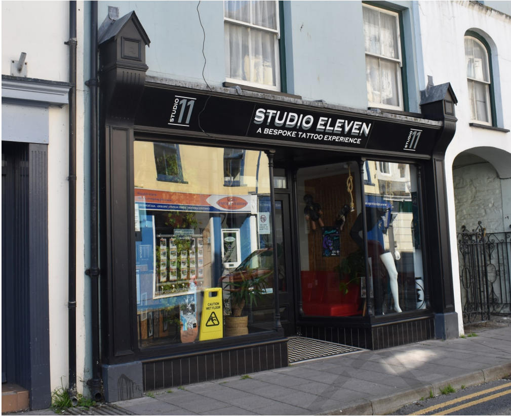
Ffigur 14 Mae atgyweirio neu ddisodli blaenau siopau gyda dyluniadau a deunyddiau traddodiadol yn gwella cymeriad yr ardal
